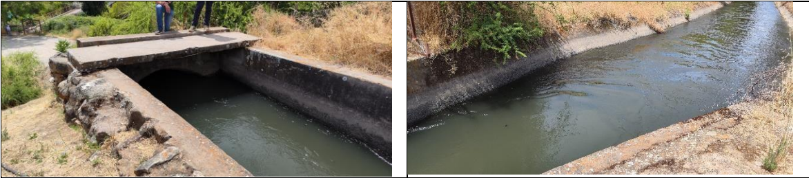
Figura 4.4 – Cámara de salida Sifón Loncomilla
