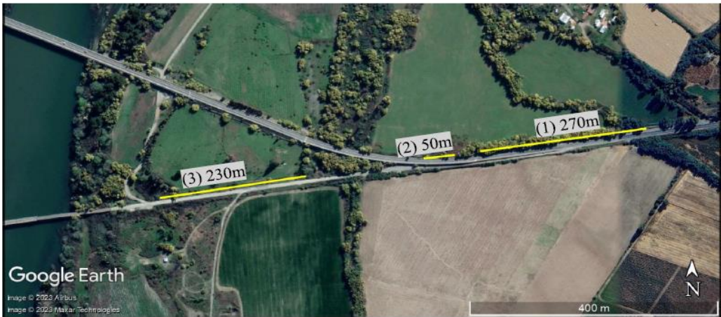
Figura 8 Vista satelital de los tramos socavados del tubo del Sifón Río Loncomilla del Canal Melozal.
