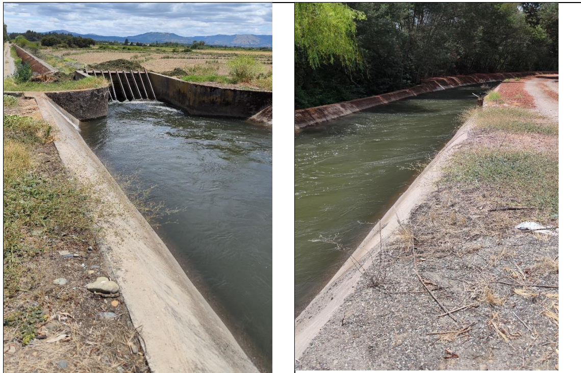
Figura 4.2 - Canal y cámara de entrada al sifón
