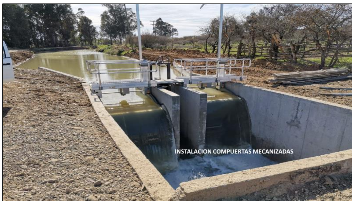
FIG. 8: Instalación de compuertas mecanizadas represas las trillizas y la higuera (canal matriz) y Alchiza (canal vaquería).
