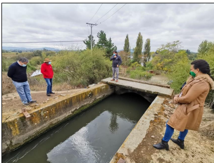
FIG. 11: Revisión del estado del puente sifón por el director nacional de obras hidráulicas Claudio Darrigrandi y la directora regional Claudia Vasconcelos.
