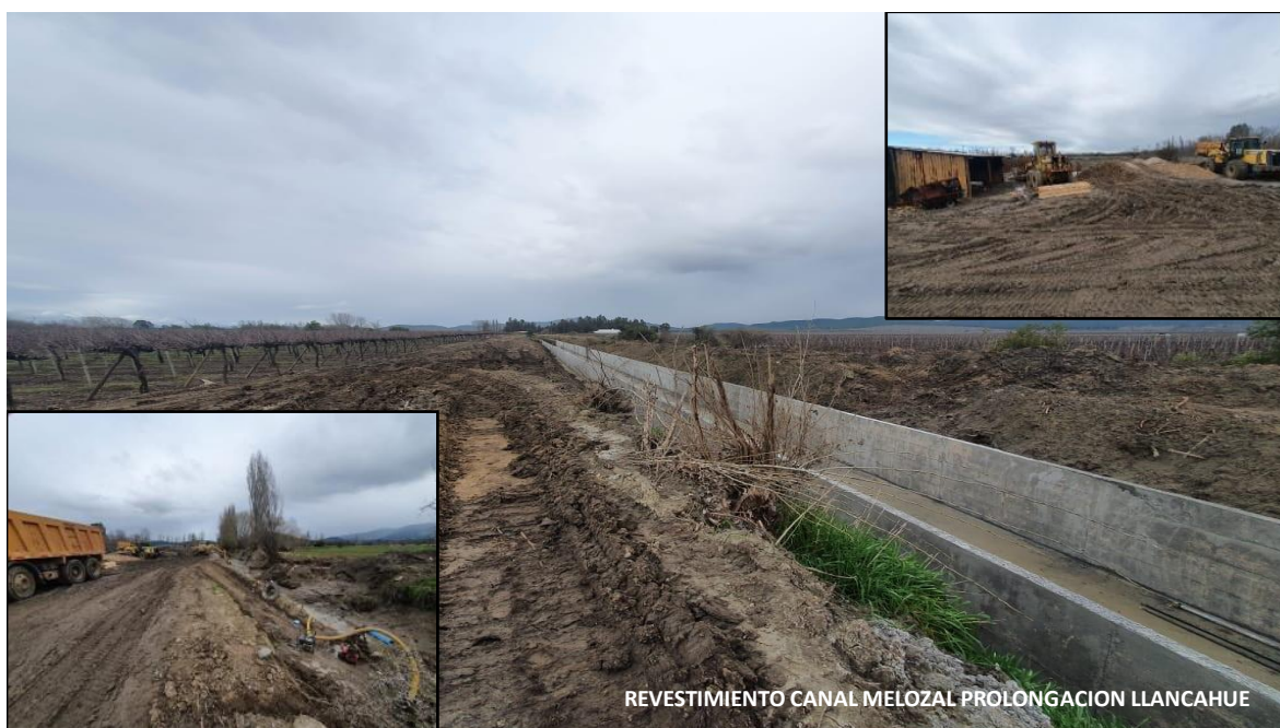
FIG. 9: Revestimiento de aproximadamente 1100 metros en sector Llancahue (Canal matriz).
