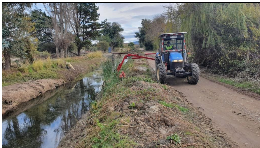
FIG. 4: Desbrozadora limpiando el canal matriz.
