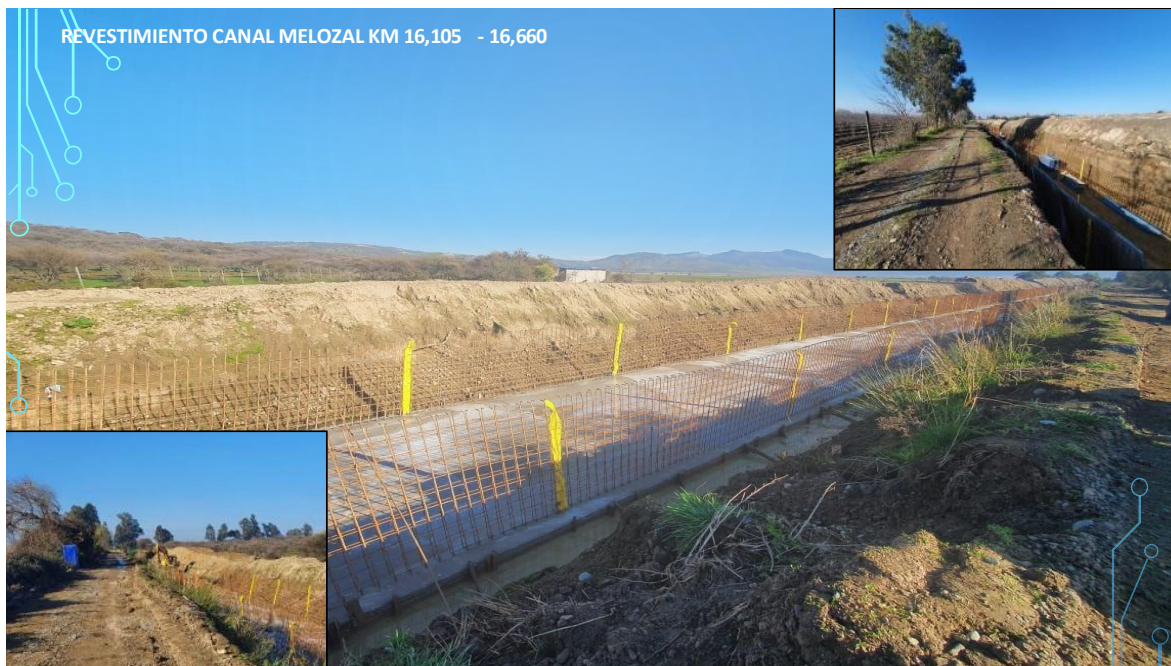
FIG. 7: 555 metros de revestimiento canal matriz sector Marimaura.
